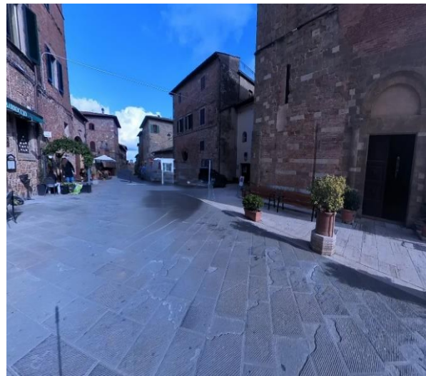
49 portale di ingresso su facciata principale
