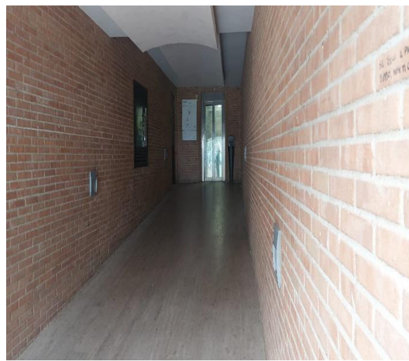
11 porta del secondo ascensore
