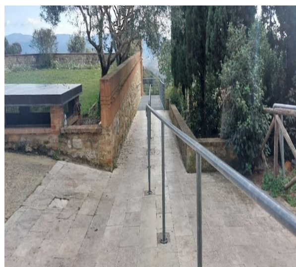
9 rampa per secondo ascensore
