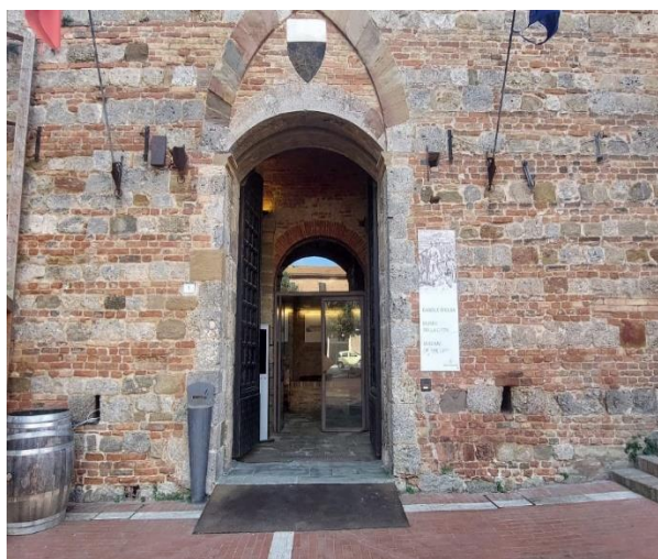
16 rampa ingresso Palazzo Comunale
